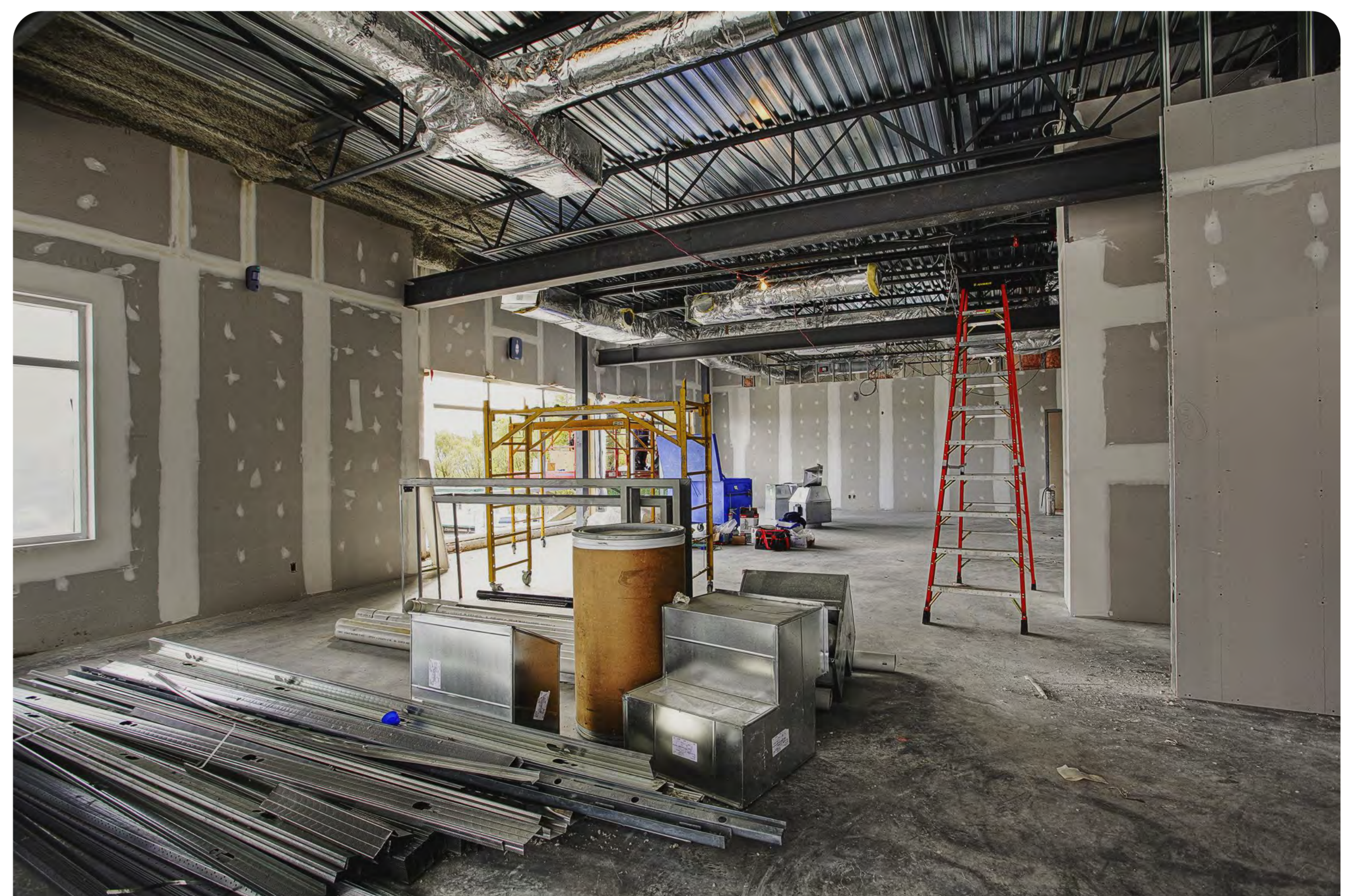
Actieve of stilgelegde bouwplaats met dure materialen en apparatuur
